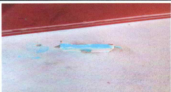
Foto 3: Cambio de chapa
