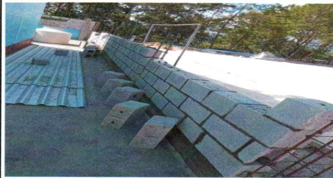
Foto 1: Trabajando muro perimetral, cambio de malla y columnas
