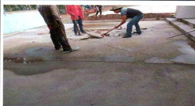
Foto 3: Demoliendo torta deteriorada
