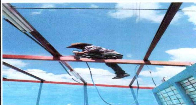
Foto 2: Aplicación de mantenimiento a estructura de soporte
