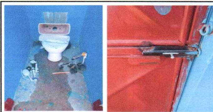
Foto 6: Cambio de quit de baños y accesorios y pasadores de puertas
